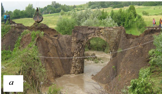
Рис. 1. Повне руйнування аркового моста (а) та розмив насипу залізничної колії (б) під час паводку
