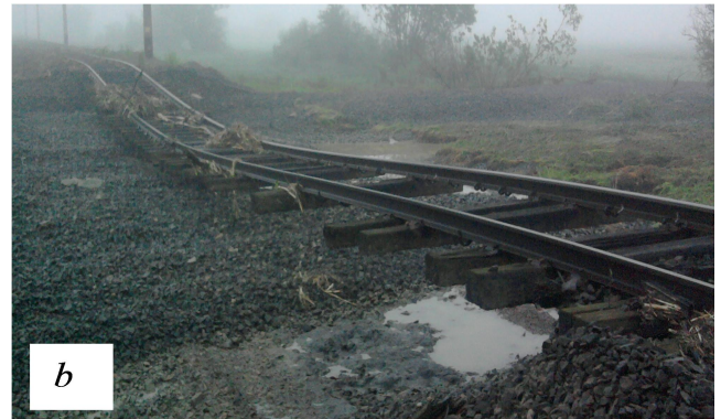
Рис. 1. Повне руйнування аркового моста (а) та розмив насипу залізничної колії (б) під час паводку
