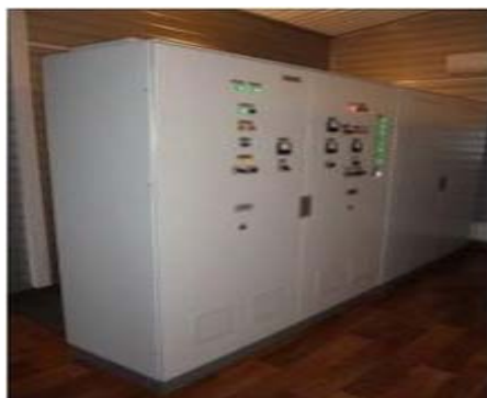
Рис. 8. Шафи управління та електроживлення мікропроцесорної централізації стрілок та сигналів
