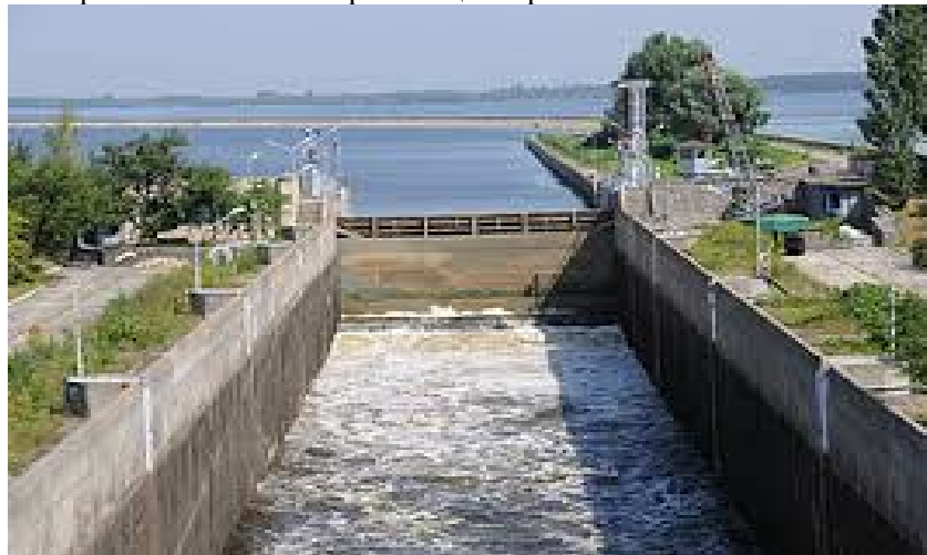
Рис. 9 – Загальний вигляд шлюзу
