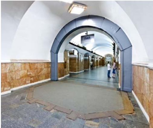
Рис. 5 – Станційний гермозатвор
