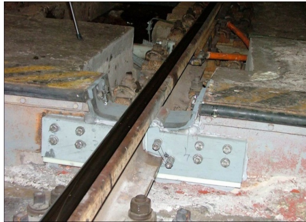
Рис. 4 – Рейка в окладі гермозатвору
