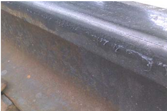
Рис. 4 – Вид рівномірно нанесеної мастильної суміші стаціонарним лубрикатором.
