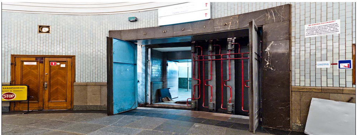
Рис. 7 – Станційний гермозатвор
