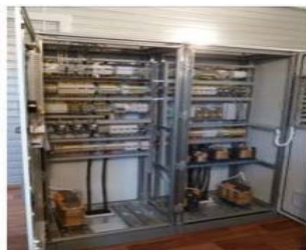
Рис. 8. Шафи управління та електроживлення мікропроцесорної централізації стрілок та сигналів
