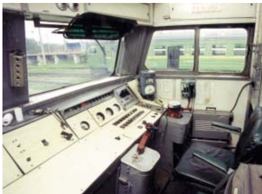
Рис. 1 Апаратура УСАВП та її розміщення у кабіні електричного поїзда
