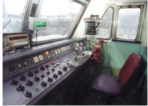
Рис. 5 Кабіна керування електровоза ЧС-7 обладнаного САВП
