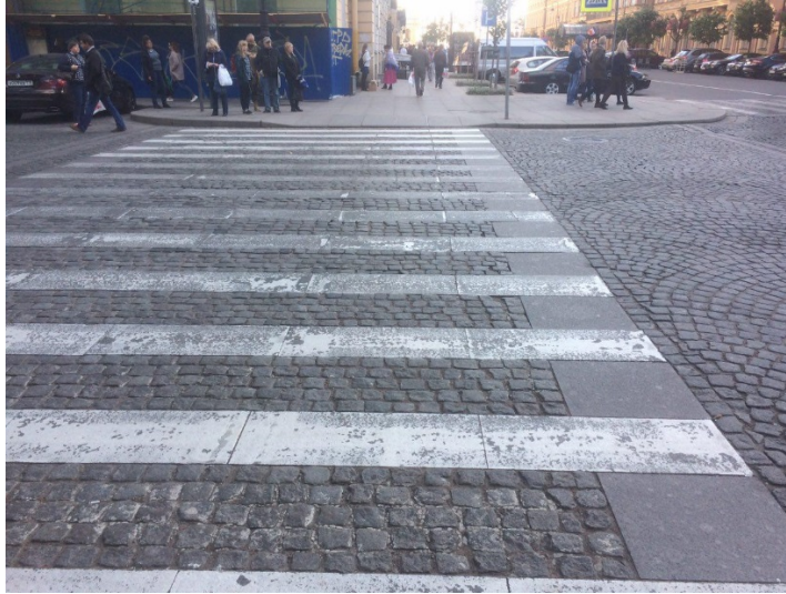
Рис. 3. Пример пешеходного перехода выложенного из камня
